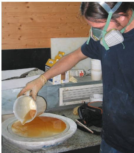
Bild 5: Ausschäumen eines Hohlraums
