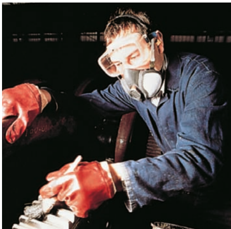
Bild 3: Lackieren eines Heizkörpers
